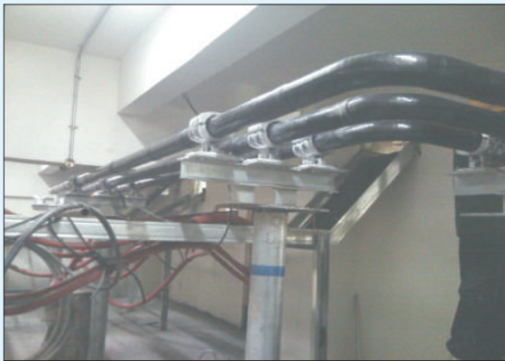
屏蔽绝缘管母线安装在电缆夹层内
