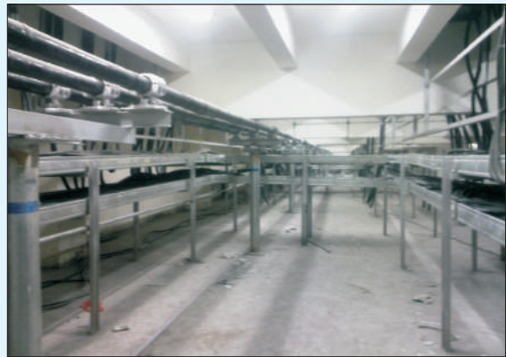
屏蔽绝缘管母线安装在电缆夹层内
